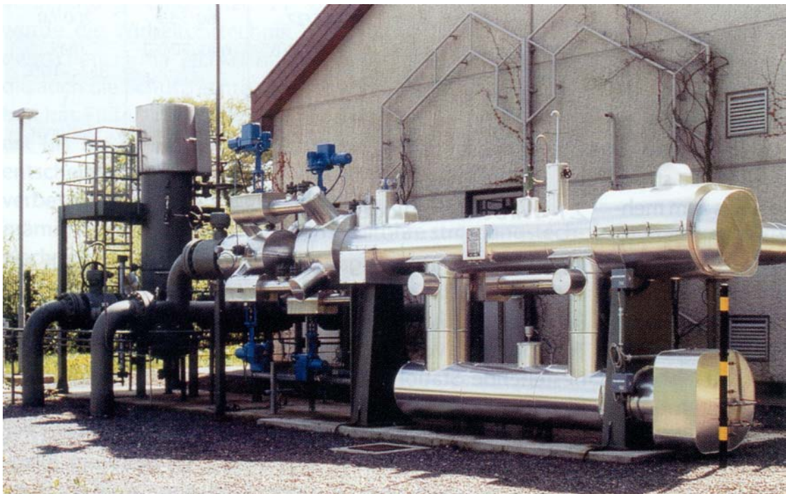
Fig. 19: Wirbelrohranlage zur Erdgastrocknung der Thyssengas GmbH in Gronau – Epe, NW.
