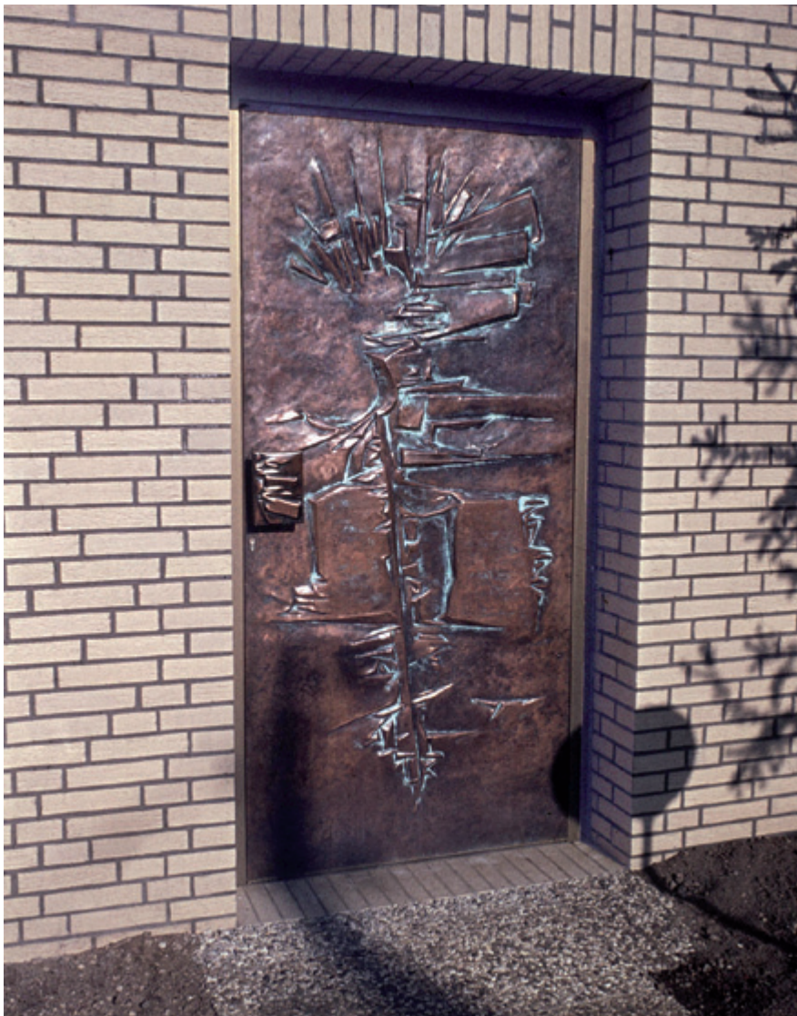
Bild 3 (DKI 4235) Türblatt aus Kupfer, 2100 x 1100 mm groß, mit Nitratpatina.
