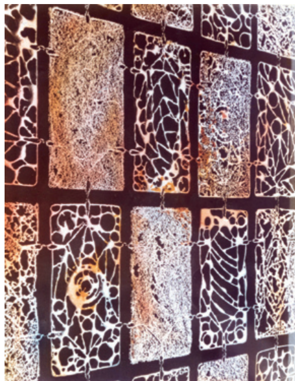
Bild 13 (DKI 4248) Zwischenwand aus Einzelelementen aus Messing, die durch Ätztechnik ornamentiert wurden. Die Platten sind gegossen. Die Farbeffekte sind durch Schwefelfärbungen (Ansatz [67]) zu erzielen.
