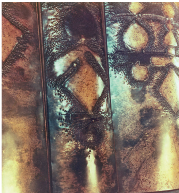
Bild 12 (DKI 4247) Messingelemente auf Aufzugsschächten in einem Bankgebäude in Kanada. Die Messingplatten sind mittels Lichtbogenwirkung ornamentiert worden, wobei bereits blaugrüne Anlauffarben entstehen. Die bräunlichen Farbzwi-scheneffekte werden mit Schwefelfärbungen erzielt.
